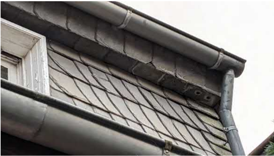
Abb. 2: Einschluflmöglichkeiten im Bereich der Verkleidung
