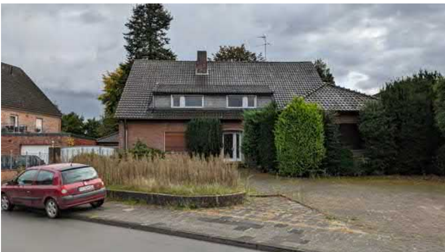
Abb. 1: Blick auf das leerstehende Gebäude
