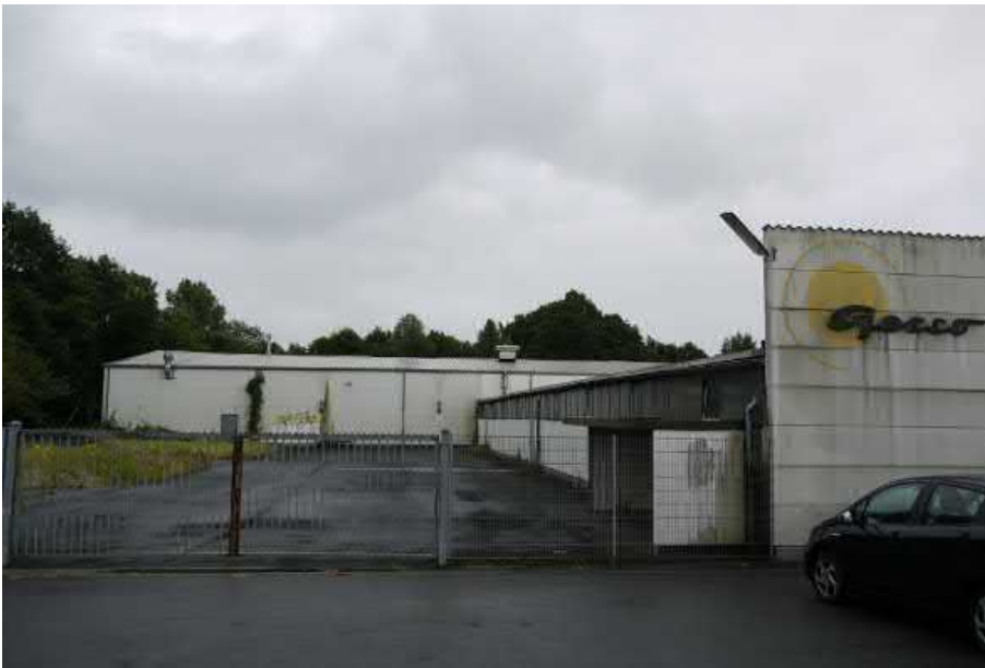
Abbildung 3: ehemaliges Betriebsgelände und -gebäude. Juli 2019.
