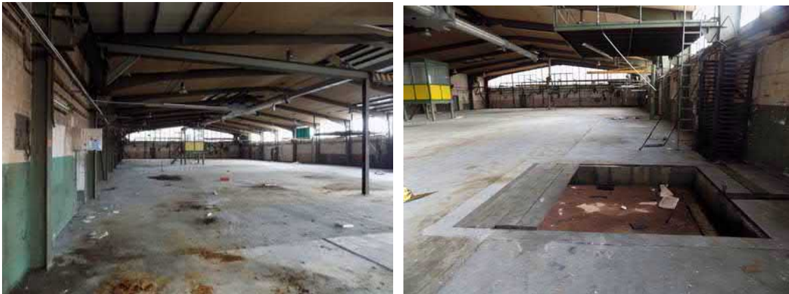
Abbildung 1: Blick in die Maschinenhalle, in den Bereichen der größten Oberflächenverschmutzungen bzw. im Bereich alter Maschinenstandorte (s. Bild rechts) wurden die Kleintrammborungen KRB 1 - KRB 4 abgeteuft.
