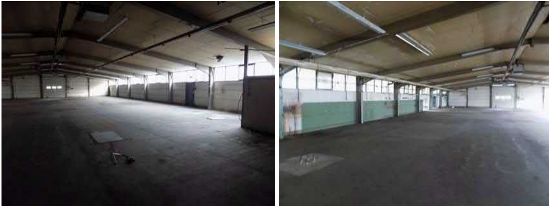
Abbildung 3: Blick in den nördlichen Teil der Halle III, hier wurden die KRB 8 - KRB 9 abgeteuft.
